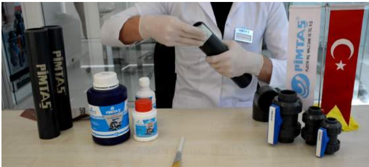
Boru ve soketin temizlenmesi
